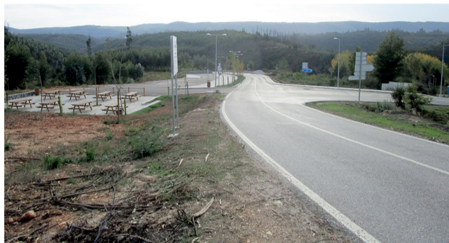
O Vimieiro com as obras concluídas será um espaço de veraneio e de lazer de grande valia em toda esta zona
